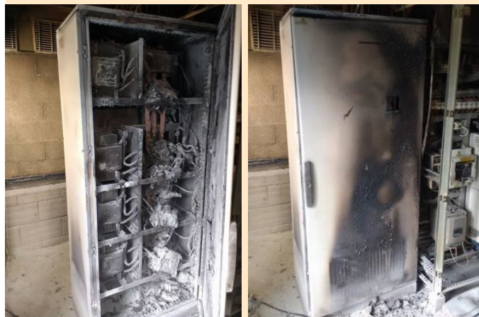
Armoire hébergeant la batterie de condensateurs détruite
